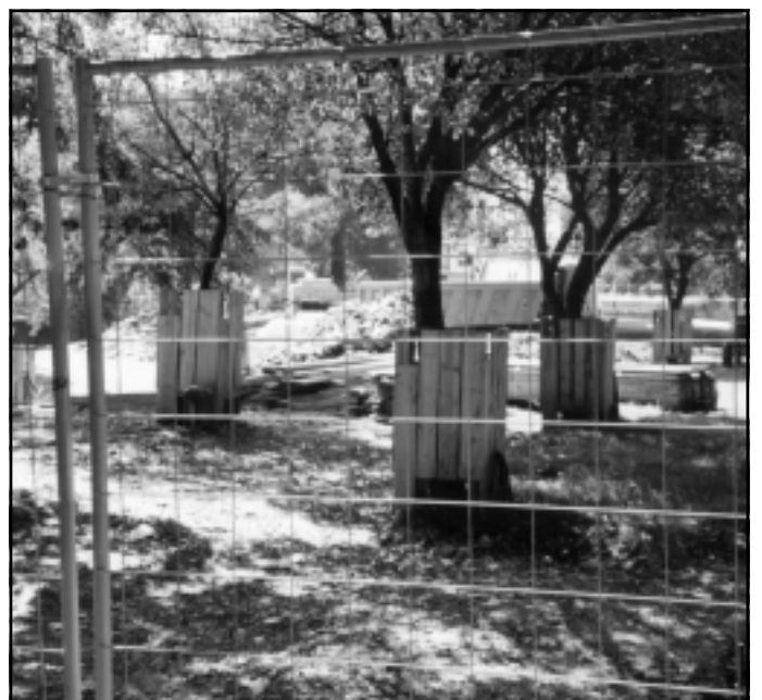
Lluny d'aquí, protecció abans d'entrar-hi les màquines.
